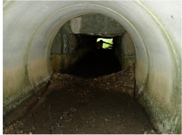
Fig 13. Johanneslund: förlängd stenkulvert utan strand.
