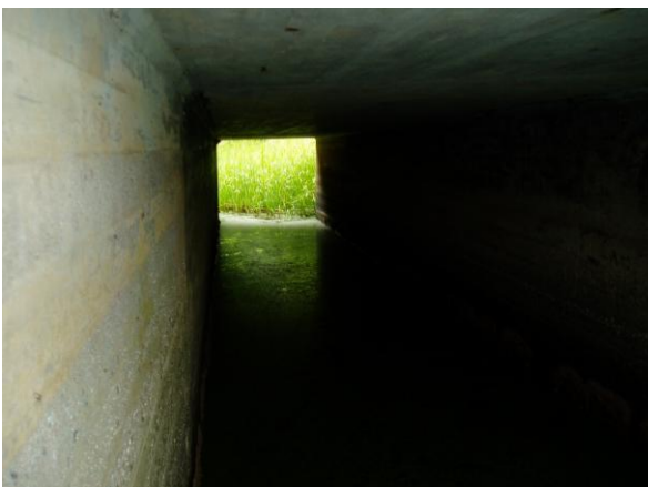
Fig 8. Berga: betongkulvert utan strand.
