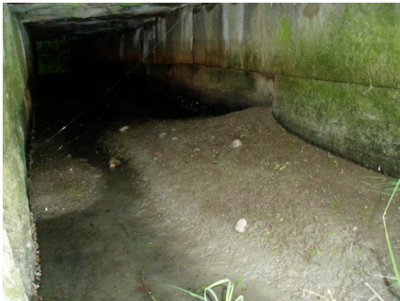
Fig 20. Rö: stenkulvert utan strand.
