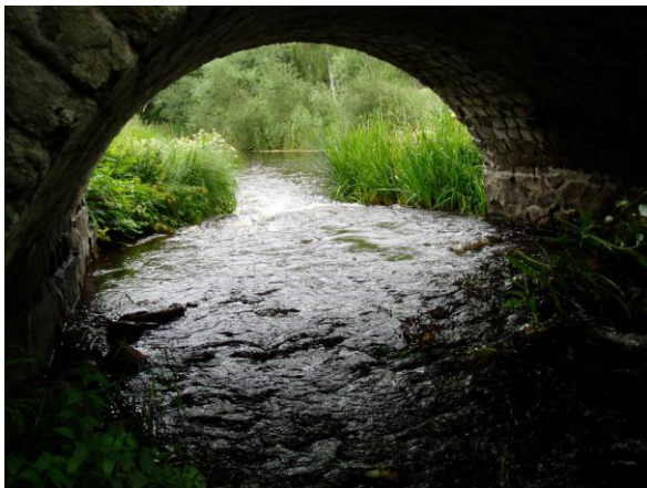
Fig 10. Skebobruk: stenvalv utan strand, periodvis hög strömningshastighet.
